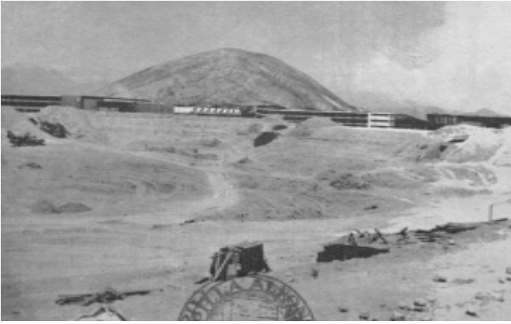
Aspecto de la construcción del Estadio Universitario.
