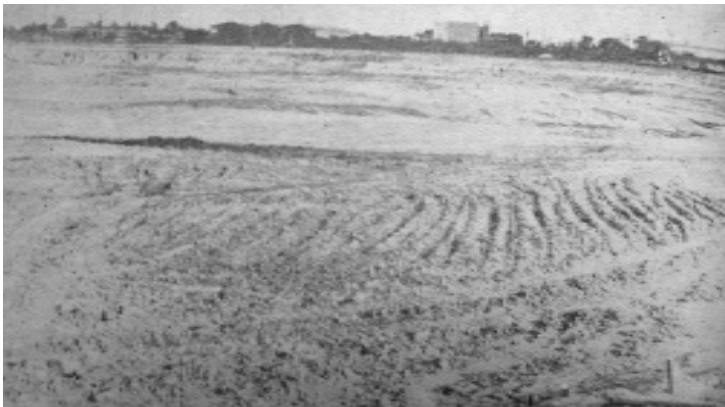
Excavación para la fosa del Estadio Universitario.
