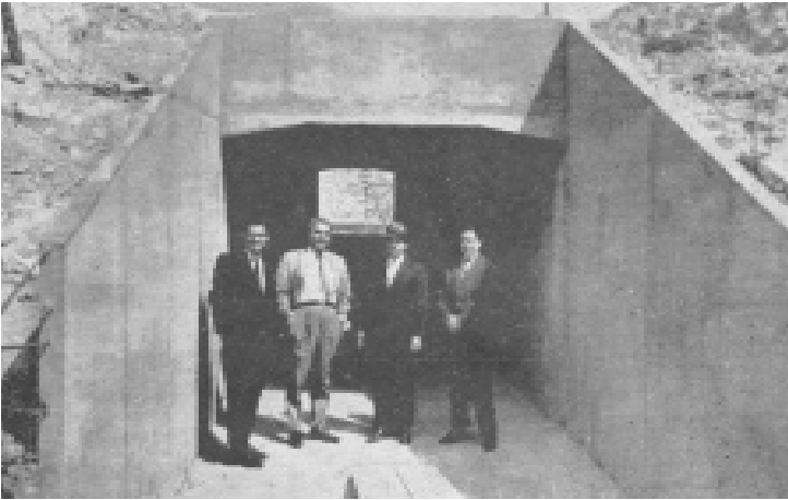
El rector, el ingeniero Toba y el secretario de la Universidad en uno de los túneles en construcción del estadio.
