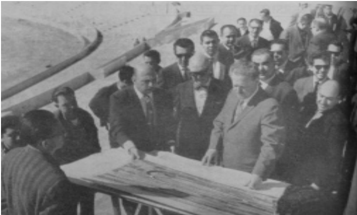
El gobernador Eduardo Livas realizó el 8 de enero una visita a la obra en construcción.
