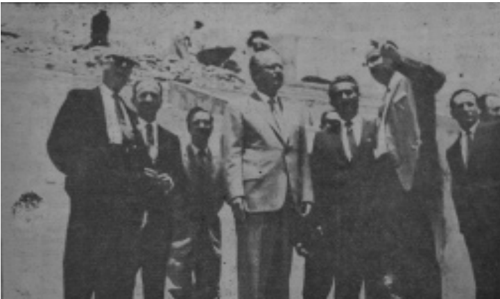
Visita del gobernador Eduardo Livas Villarreal a las obras del estadio, enero de 1962.
