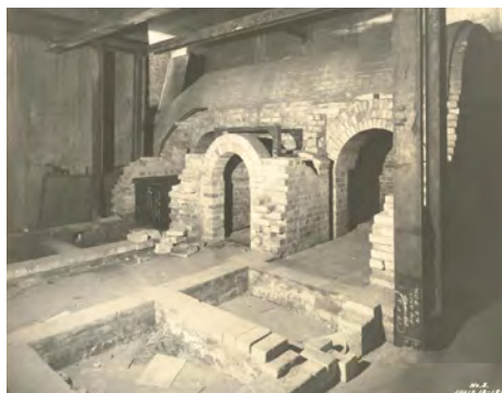
Figura 34. Reparación de bóveda, Hornos recalentadores del Molino de 40". Fotógrafo: E.E. Barros. AHF.
