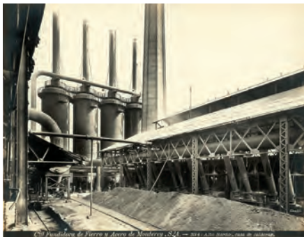
Figura 13. Silbato en el techo de la Casa de Calderas del Horno Alto N° 1. Fotógrafo: Guillermo Kahlo. C.a. 1909.
