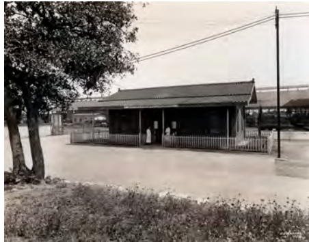
Figura 16. Fotografía: E.E. Barros. Vista general de la Enfermería. c.a. 1935.
