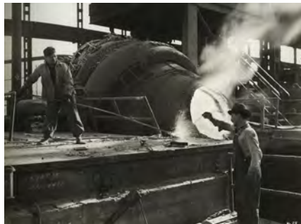
Figura 42. Fundidor y Laboratorista revisando una muestra de acero del Convertidor Bessemer. Fotógrafo: E.E. Barros. 1936.
