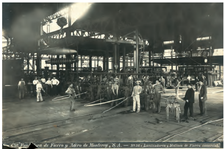
Figura 4. Molinos de fierro comercial 18"-12". Fotografía: Guillermo Kahlo. c.a. 1909.
