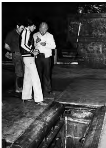
Figura 30. Trabajadores revisan un hueco en el área de corte en frío en Aceros Planos. Fototeca, N.L. N° Inv.
