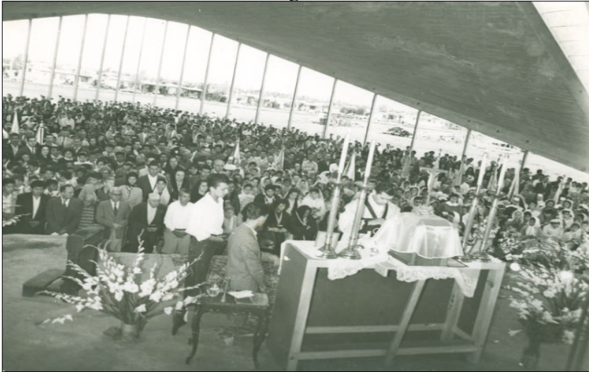
Celebración de la misa antes que se incorporaran los vitrales en la estructura. Ca. 1963. Acervo Histórico FEMSA.
