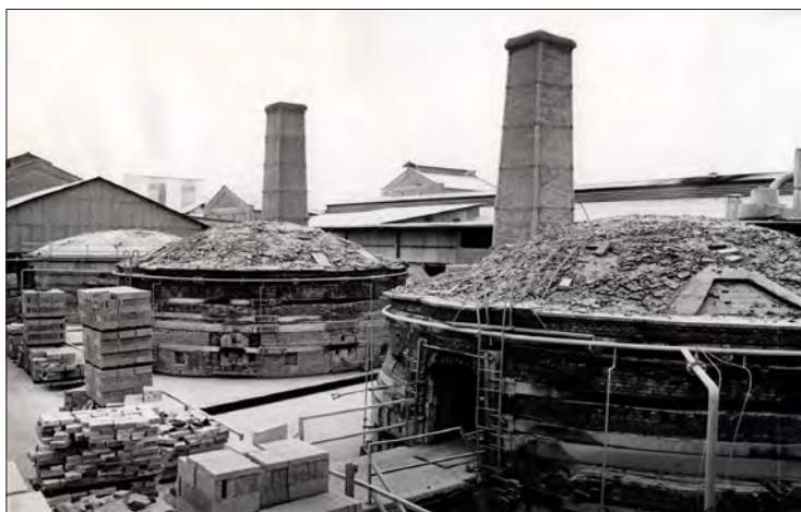
Figura 43. Hornos colmena para la fabricación de ladrillos refractarios. Sin identificar. Monterrey, N.L., México. D.R. ©9839 Fototeca Nuevo León – CONARTE, Fondo: Fundidora.
