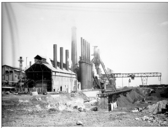
Figura 33. Calderas M.A.N. y equipo auxiliar del Horno Alto N° 1, 1933. Eugenio Espino Barros. Monterrey, N.L., México. DR. ©60291 Fototeca Nuevo León – CONARTE, Fondo: Fundidora.
