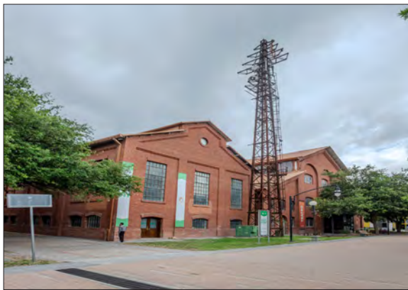
Figura 12. Planta Convertidora de Energía Eléctrica, Fachada oeste restaurada en 2001. (SINTRAM). Fotografía: Iván Montalvo 2023.
