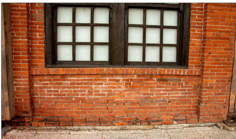
Figura 2. Pared poniente del Edificio “Ingenios de Soplo” construido con acero estructural de la American Bridge, forrado con ladrillo adquirido en Galvestón, Tx., y cemento Dyckerhoff. Se puede apreciar el ladrillo nuevo en color oscuro y pasta blanca en la parte baja de la ventana, contrario al cemento Dyckerhoff, parte inferior. Fotografía: Iván Montalvo, 2023
