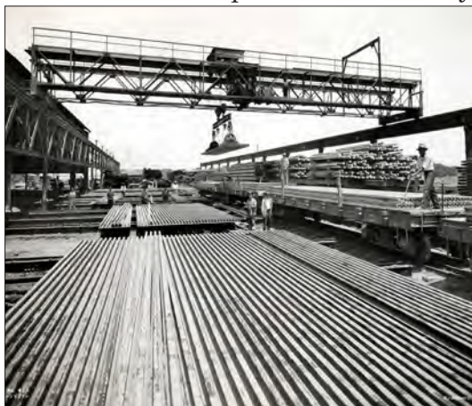
Figura 38. Rieles de 112 libras por yarda en las camas de Fierro estructural después de haber sido inspeccionadas en el Dpto. de Embarques, 1933. Eugenio Espino Barros. Monterrey, N.L., México. DR. ©N° Inv. 47226 Fototeca Nuevo León – CONARTE, Fondo: Fundidora.
