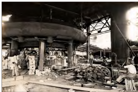
Figura 45. Albañiles ponen ladrillo refractario en el interior del Horno Alto N° 1. Monterrey, N.L., México. D.R. ©N° Inv. 40078 Fototeca Nuevo León – CONARTE, Fondo: Fundidora.
