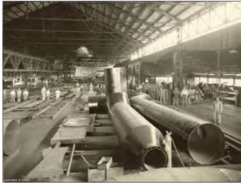
Figura 39. Taller de Estructuras. Al frente, ductos del Horno Alto N° 2. Eugenio Espino Barros. Monterrey, N.L., México. DR. ©Fototeca Nuevo León – CONARTE, Fondo: Fundidora.
