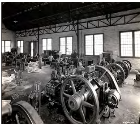
Figura 48. Trabajadores de Pernos en Frío. Eugenio Espino Barros. Monterrey, N.L., México. D.R. ©46896. Fototeca NL- CONARTE, Fondo: Fundidora.
