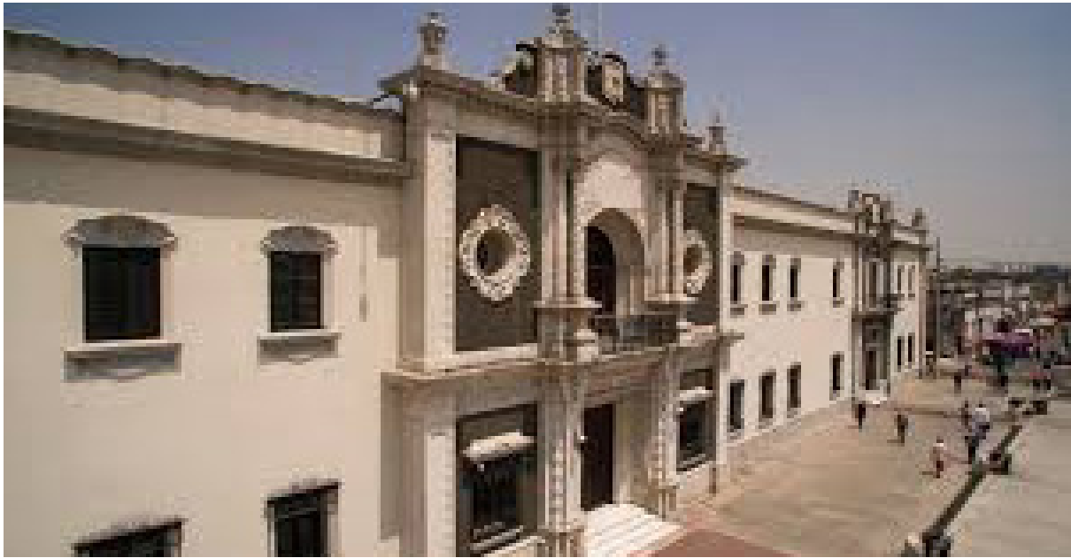
■ El edificio del Colegio Civil albergó a la rectoría de la naciente UNL.
