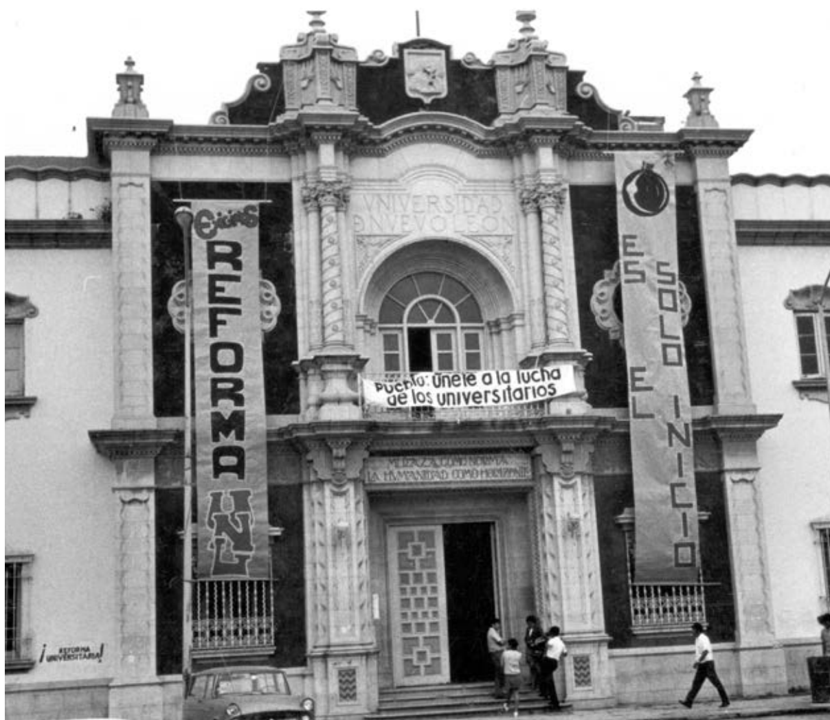
■ El edificio de Colegio Civil volvió a ser sede de los reclamos estudiantiles. Fuente: Archivo Carlos Ruiz Cabrera.
