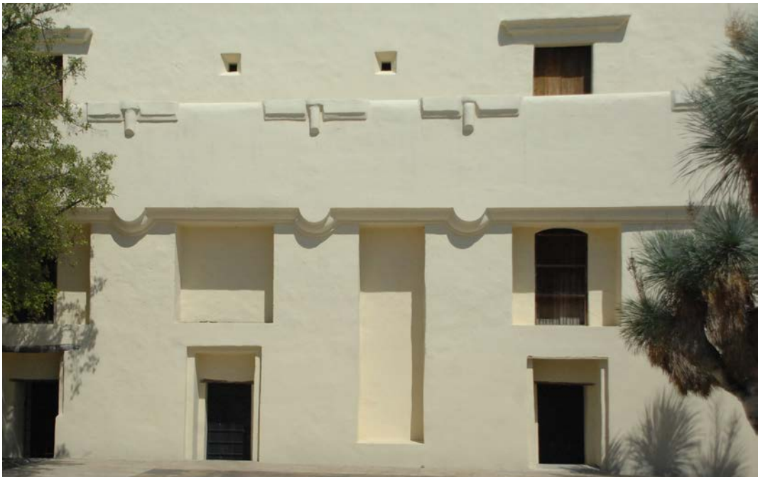
Fachada en patio principal. Se aprecia el acceso al sótano o semisótano, los muros dobles que forman nichos y volados o saliente de sillar con molduras, lo que permite un pasillo, cuyo pretil se aprecia fue construido con ladrillo. Fotografías: Pedro Martínez y Félix Torres Gómez.
