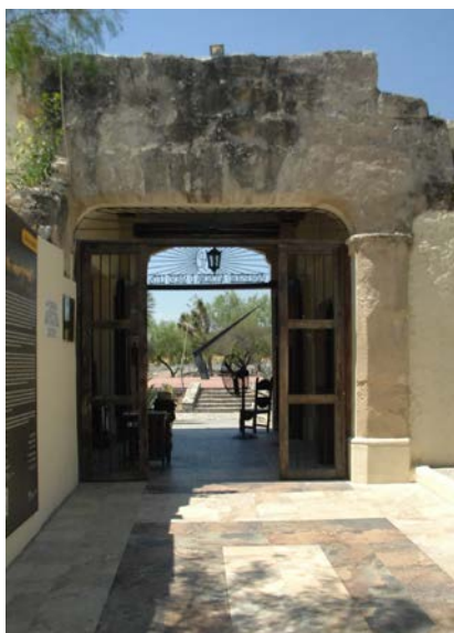
Zaguán. Vista del interior al exterior. No contaba con su portón de madera. En la restauración del arquitecto Pedro Martínez, secciones como esta se dejaron con el sillar aparente, sin el aplanado original de cal, arena y baba de nopal que debió tener. Después alguna pintura de cal, baba de nopal y algún colorante natural. Fotografías: UANL y Félix Torres Gómez.
