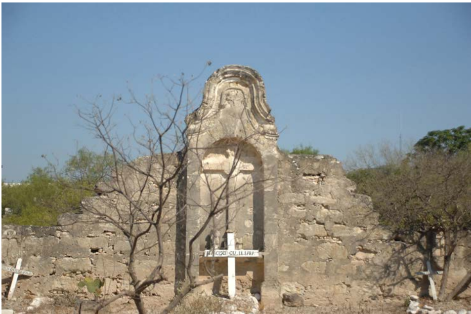
Panteón. Esta fachada a modo de altar, con cruz labrada según un levantamiento de planos y fachadas previo del INAH, tenía labrada la fecha 1840, que coincide con la fecha de su entrada en funcionamiento según los registros de defunciones, pero esta fecha ya no se aprecia en la foto antigua.
