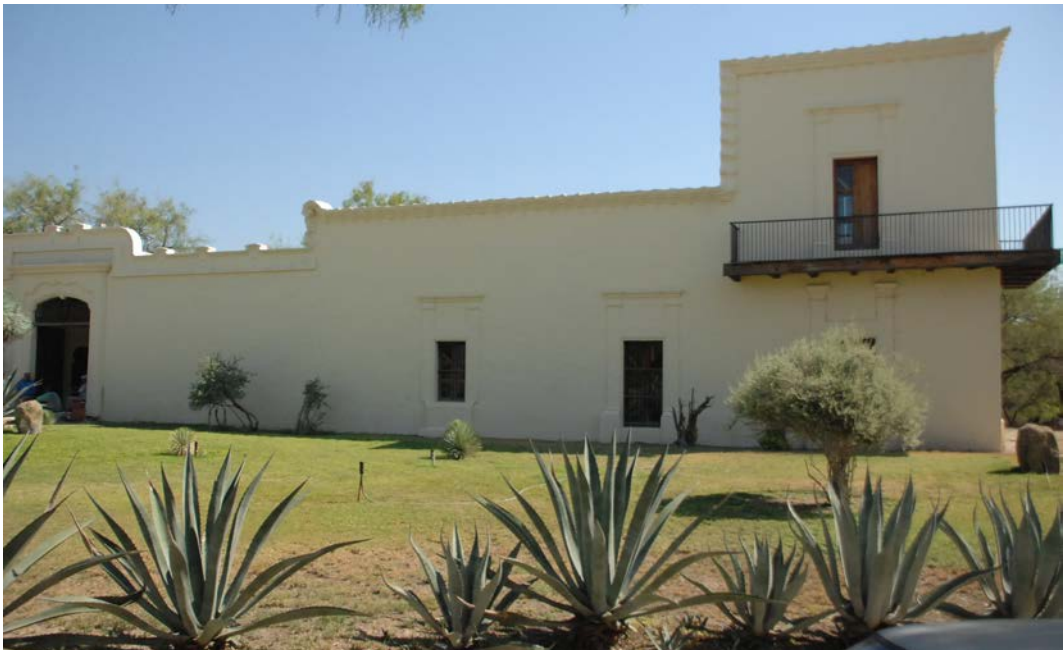
Fachada principal oriente. En esta fotografía se aprecia en el muro los huecos de vigas del balcón volado, y un hueco de puerta inmediato al zaguán de entrada. Esa puerta la clausuró el arquitecto Pedro Martínez. Fotografías: Pedro Martínez y Félix Torres Gómez.
