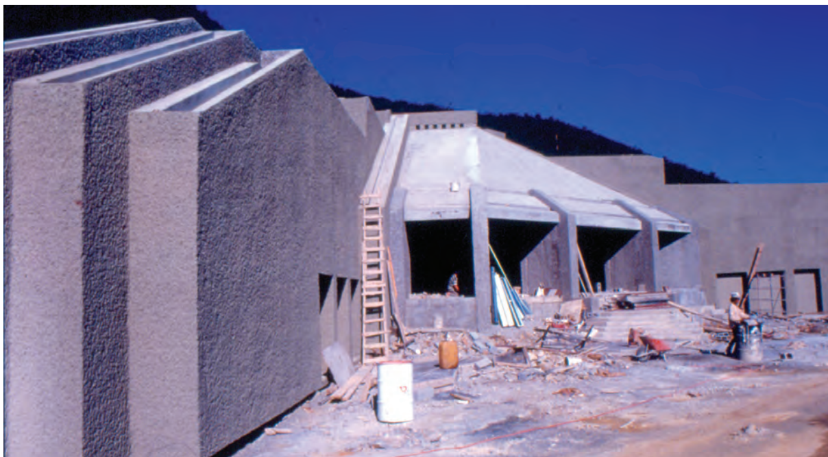
■ El Centro de Apoyo y Servicios Académicos (CASA), en la imagen en el proceso de construcción, se conformó como una dependencia que desarrolló los programas de fortalecimiento y superación docente. Fuente: CDyAH.
