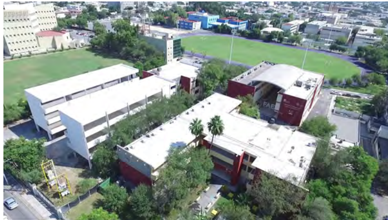
■ Instalaciones de la Facultad de Enfermería, fábrica de héroes que nos ayudaron con la pandemia de COVID. Fuente: CDyAH-UANL.
