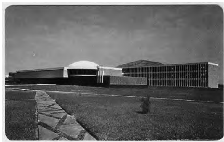
■ Edificio original de la Facultad de Arquitectura. Fuente: CDyAH-UANL.
