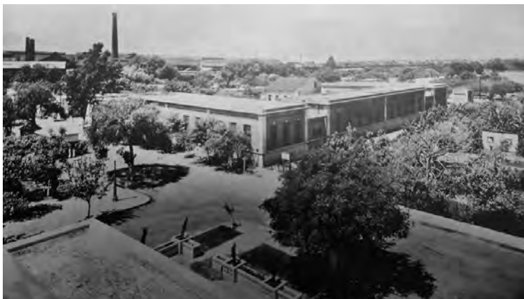
Imagen 12. Construcción de la Escuela Acero. Reprografía Informe Anual 1939. Archivo Histórico Fundidora.
