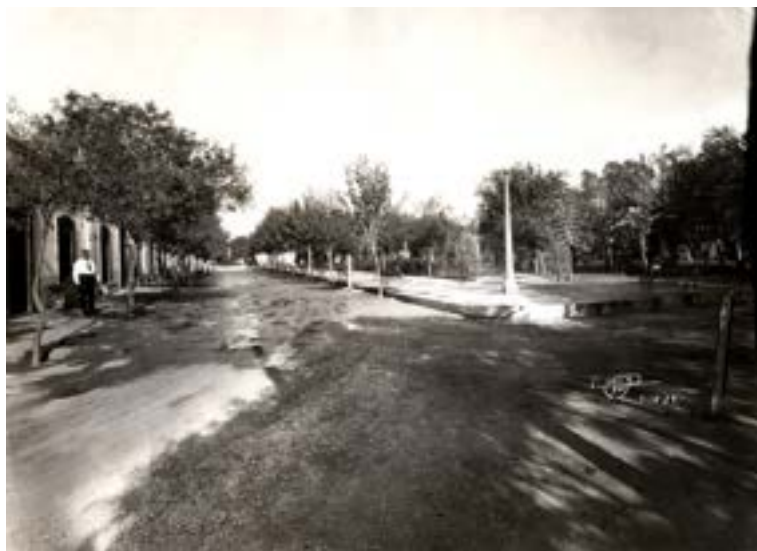
Figura 3. Parque Prisciliano Elizondo en la Colonia Acero. 18-Jul- 1929. Refugio Z. García. Monterrey, N.L. N° Inv. 52465 Fototeca –Centro de las Artes | CONARTE, Fondo: Fundidora.
