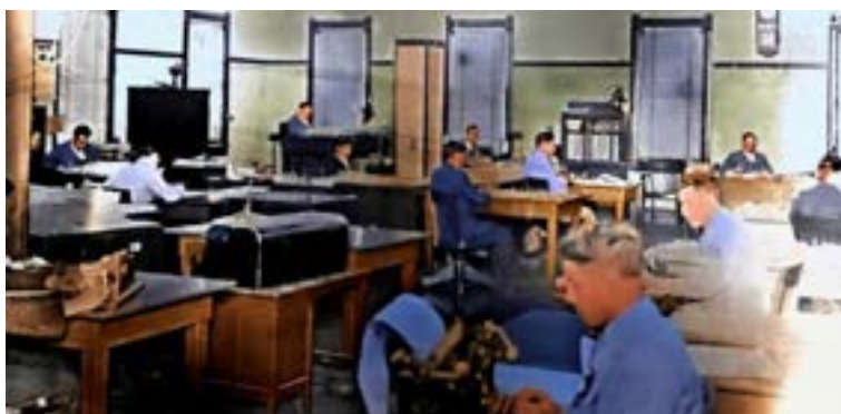
Figura 52. Secretarios administrativos laboran en una sección de las Oficinas Generales. Fotógrafo: Martínez. Ca. 1930. Fondo: Fundidora. Archivo Histórico de Fundidora (AHF).
