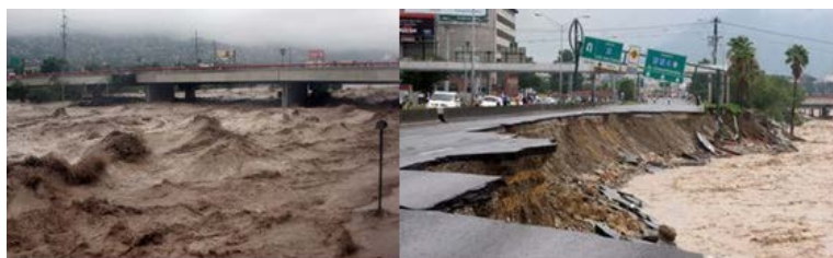
Imagen 7. Fotos del huracán Alex en 2010, corriente del río Santa Catarina y daños del AAM.
