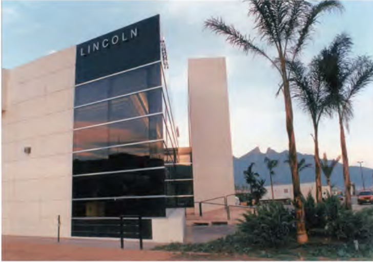
Fig. 140 Detalle marco acceso fachada oeste
