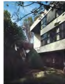
Fig. 18 Detalle de fachada posteriores
