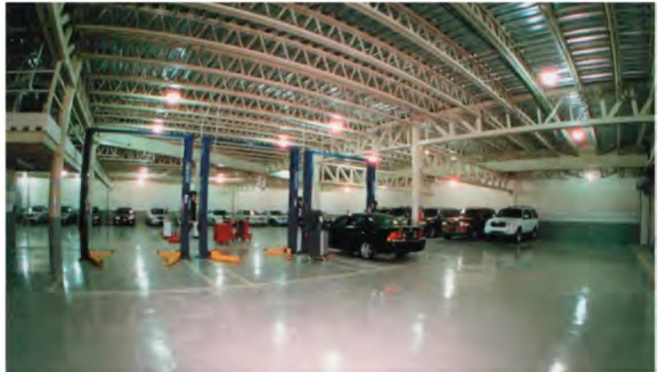
Fig. 151 Almacén autos nuevos y servicio en sótano
