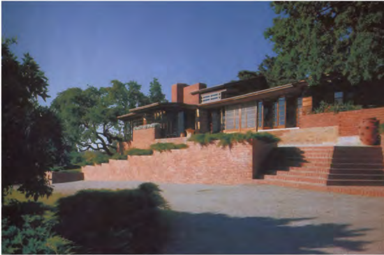
Fig. 95 Fachada posterior de la Casa Hanna
