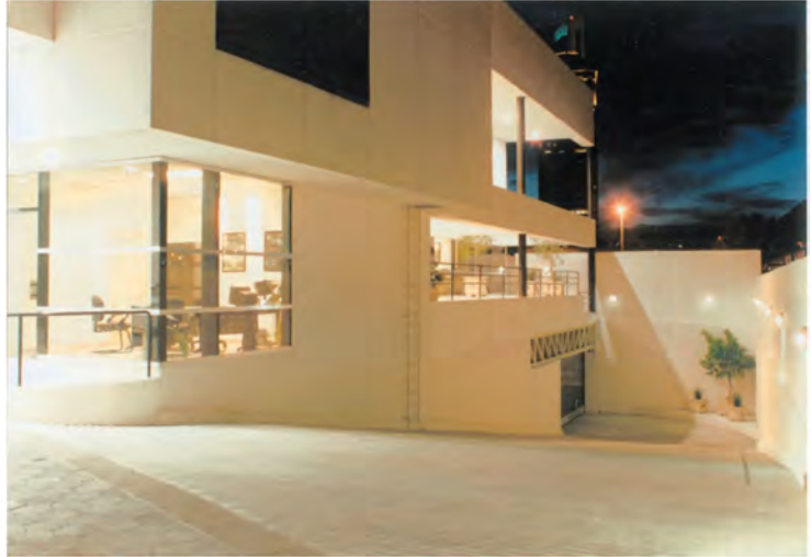
Fig. 150 Fachada norte, vista de rampa hacia entrada a sótano
