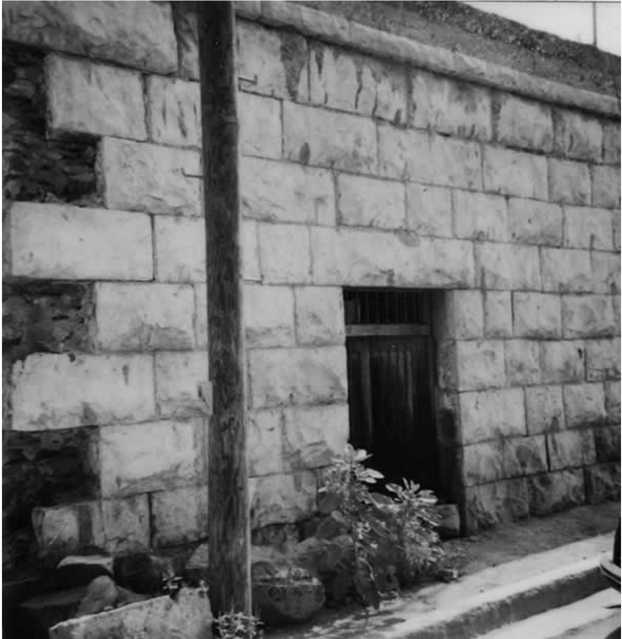
Fotografía 30. Fachada de la primera escuela construida con material extraído del cerro del Topo Chico.
